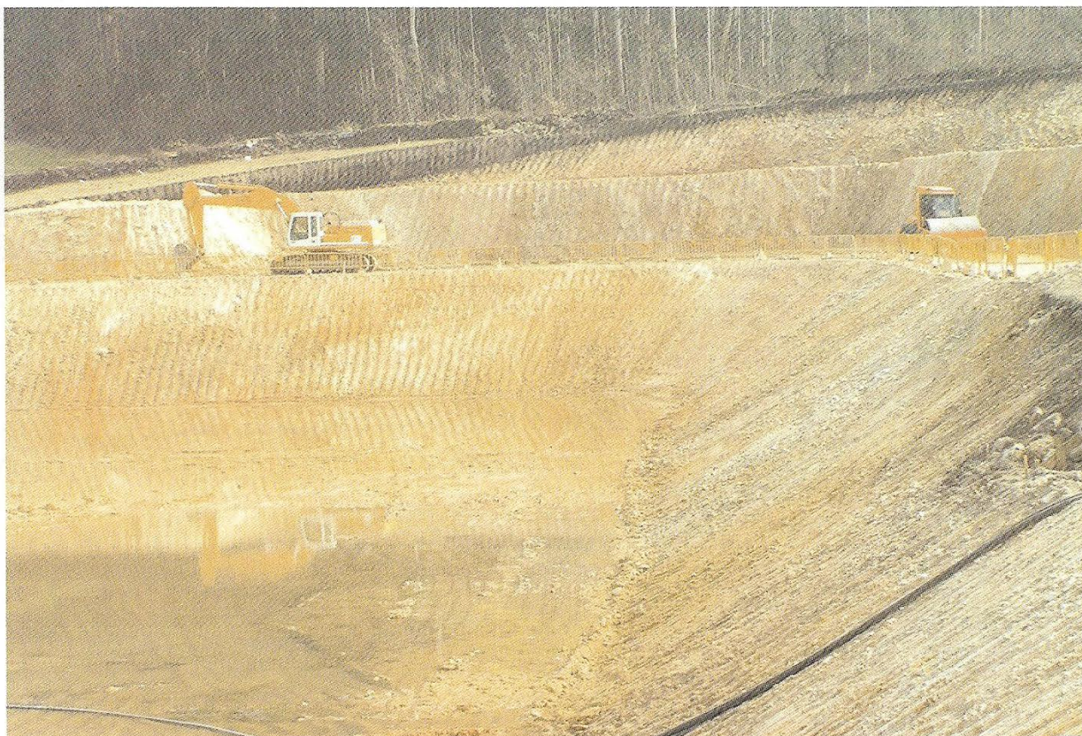
Estado actual de las obras del vaso de la pista
