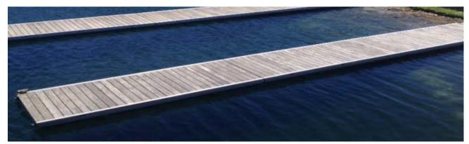
b. Pantalán de entrada en el agua: será de madera con 24 metros de longitud con 3 metros de anchura y una elevación sobre el nivel del agua de 30 cm. Para entrar en este pantalán desde el porteo terrestre usaremos una rampa de 11 metros de longitud y 2 metros de anchura con una inclinación variable en función de la marea en cada momento.
