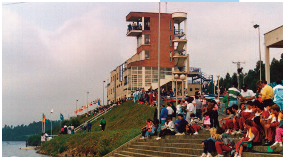
Instalaciones de Santa Cruz de Trasona, en Corvera de Asturias. Foto J.R. Inclán.
