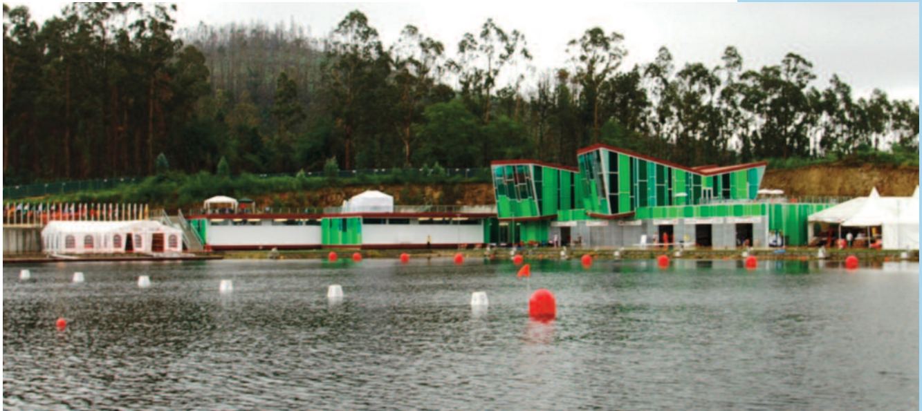
Instalaciones de Verducido, sede del Campeonato de Europa de aguas tranquilas en 2007. Foto archivo.
